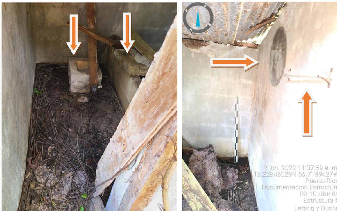
**Fotos - 23 y 24- Vista del interior de la ESTRUCTURA 11 del INFORME 2012, observándose parte del muro construido en bloques y cemento que separa la letrina de la ducha. Se observan planchas de zinc representando el techo de la estructura, así como una tablilla de cristal y un espejo. (Archivo de la Arqla. Virginia Rivera Calderón).**
